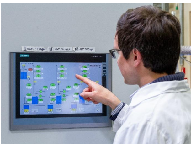
Fraunhofer IGB entwickelte eine anwendungsoptimierte Wasseraufbereitung mithilfe sensorgestützter Prozesssteuerung. Ein Hauptaugenmerk liegt dabei auf der Etablierung effizienter Daten- und Kommunikationsinfrastrukturen. Quelle: Fraunhofer-Institut für Grenzflächen- und Bioverfahrenstechnik IGB
